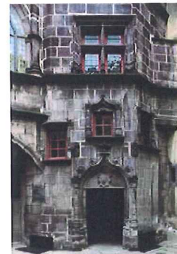
Hôtel de ville Edifice Renaissance
